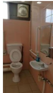
坐厕旁设有水平扶手及垂直扶手
